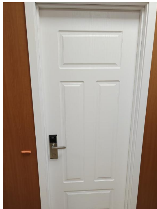
照片10 污物门内部单向开关
